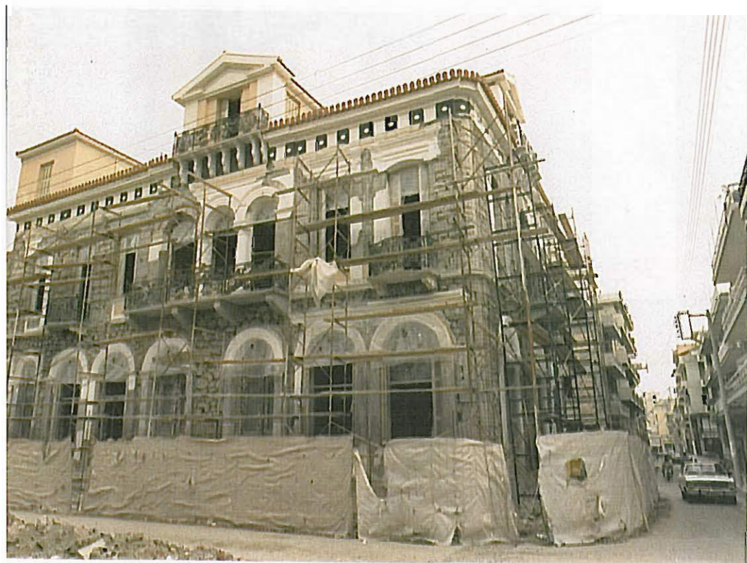
«Ζουμπούλειο». Το κτίριο της Σχολής Χορού. (επισκευαζόμενο μετά τους σεισμούς)
