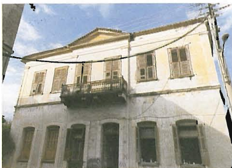
Κτίριο Τσίγκου: θα στεγάσει υπηρεσίες του Δήμου
