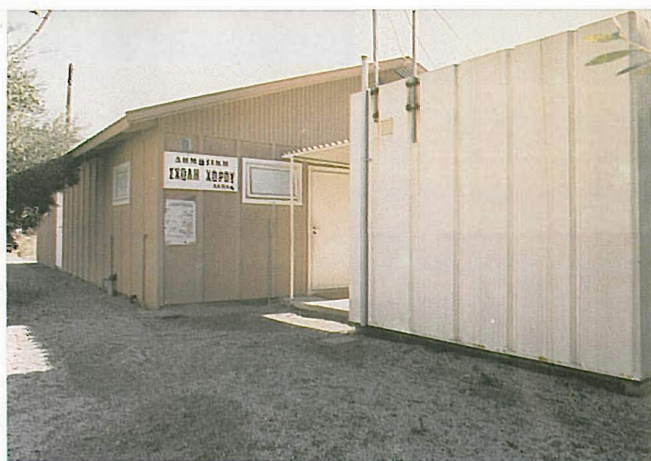
Τα λυόμενα όπου στεγάζουν τη Σχολή Χορού μετά το σεισμό.
