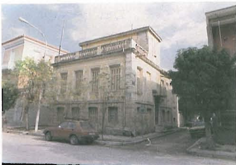
Το κτίριο Αναγνωστοπούλου, που θα στεγάσει την Πινακοθήκη της ΔΕΠΑΚ
