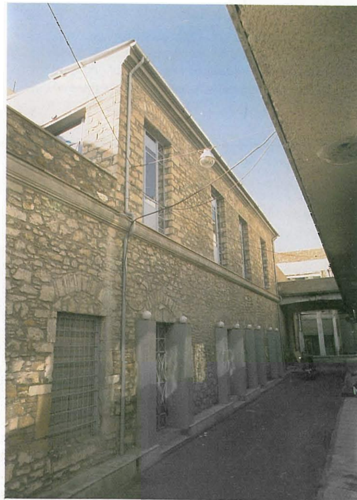
Το κτίριο που στεγάζει την Κινηματογραφική Λέσχη Καλαμάτας.
