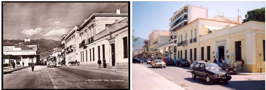
Η ΤτΕ και η ΕΤΕ στο βάθος το 1950 και το 1990 μετά την κατεδάφιση της ΕΤΕ.
