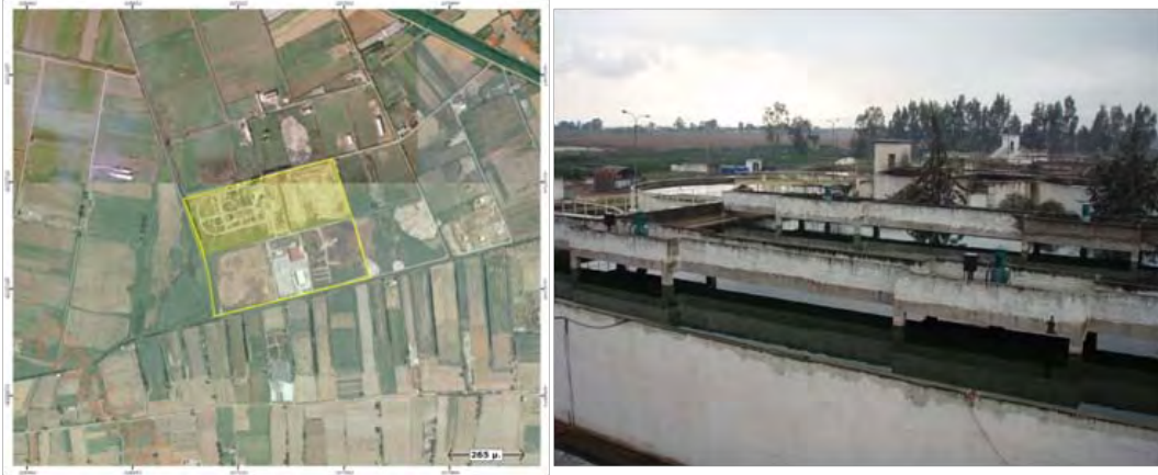
Εικόνα 4.3.4.5.2: Ο βιολογικός καθαρισμός λυμάτων Καλαμάτας.
